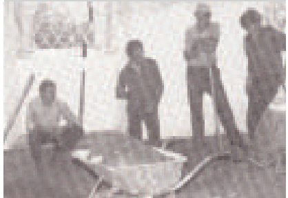
Begonnene Sanierung der Sakristei
